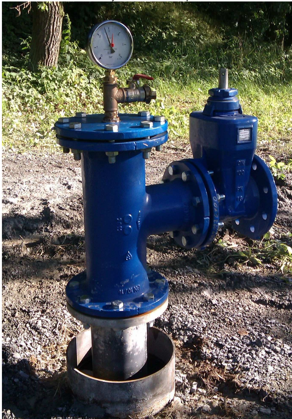
Obr. 2 Uzavření vrtu tlakovým zhlavím se šoupětem a manometrem
