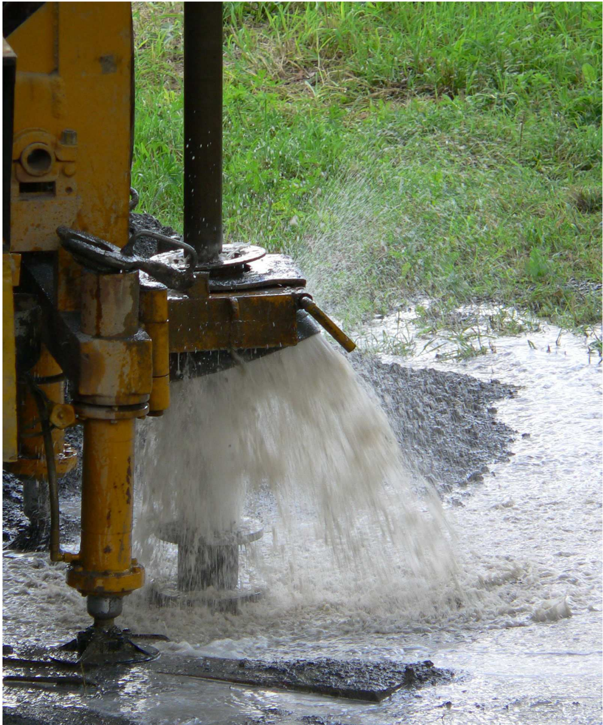
Obr. 1 Naražení tlakové zvodně vrtnou soupravou
