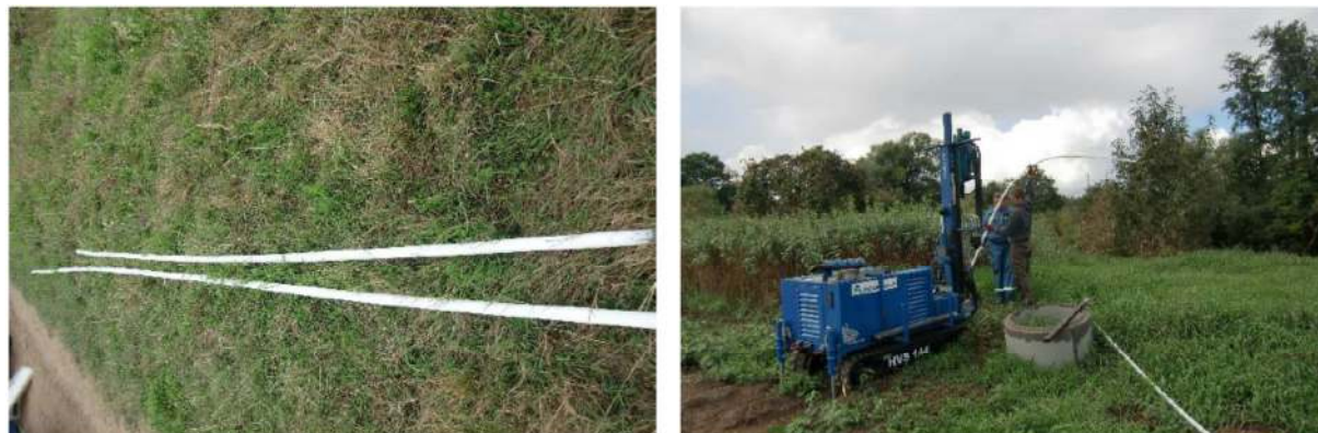
Stavebnicová konstrukce pažení monitorovacího vrtu a její instalace
