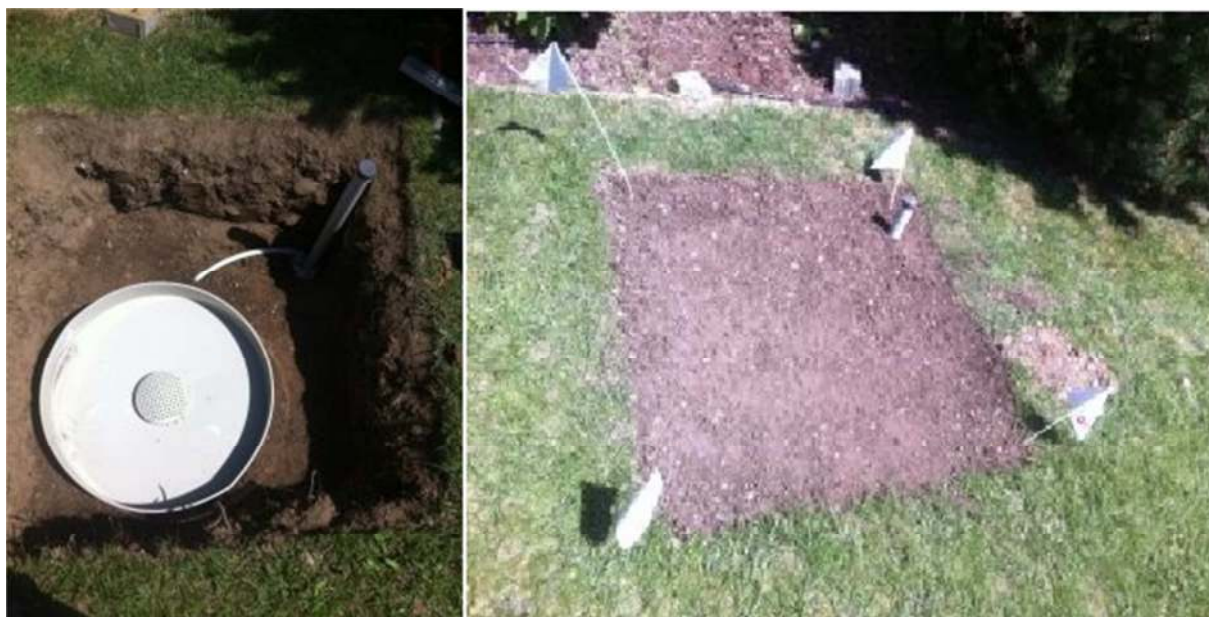
Konstrukce a umístění jímače gravitační vody
