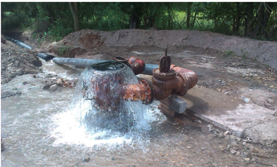
Vrt Lo 15/4 po odstranění krycí desky zhlaví
