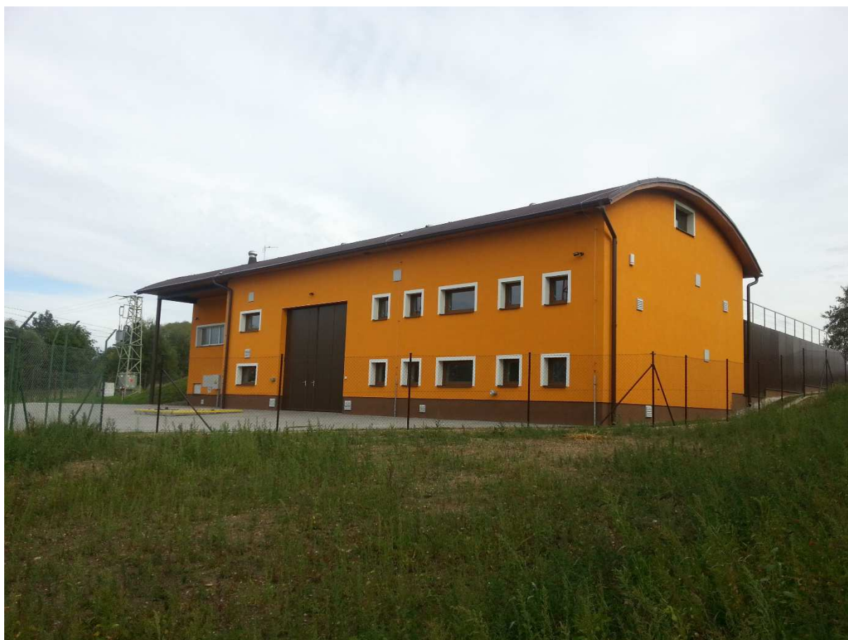
Úpravna vody Choceň
