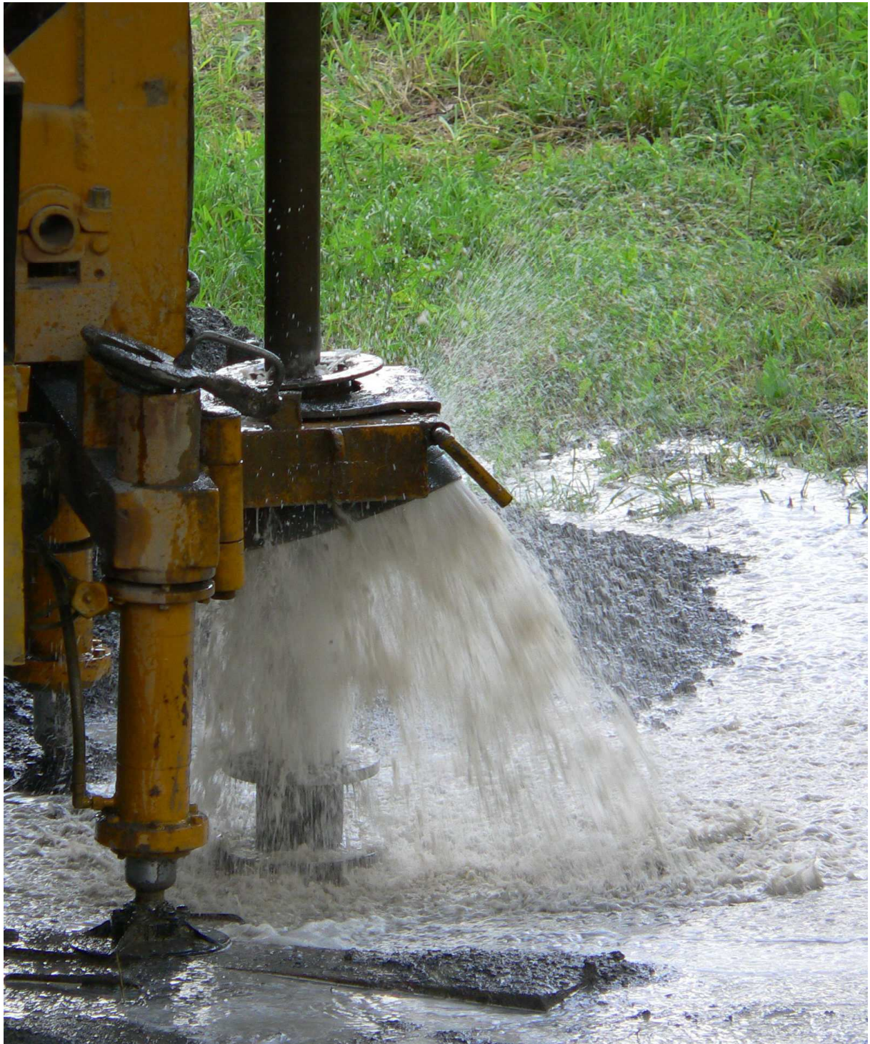
Obr. 1 Naražení tlakové zvodně vrtnou soupravou
