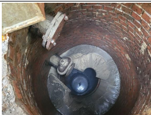
Pohled na dno šachty s ukončením cementačních tyčí
