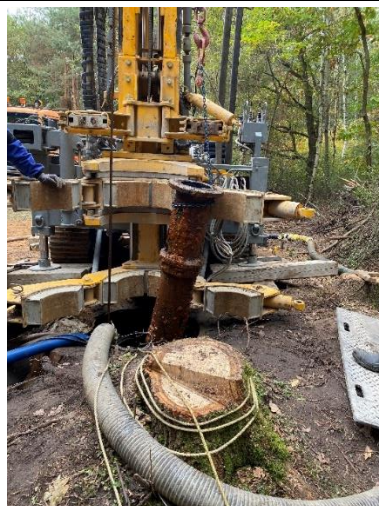
Vytahování litinové pažnice ø 200 mm
