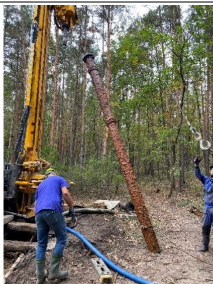
Vytahování litinové pažnice ø 225 mm
