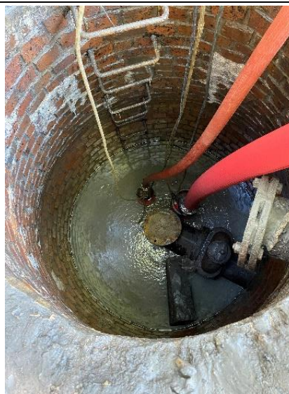
První odčerpání obslužné šachty
