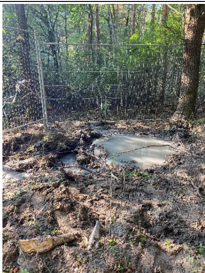
Pohled na přetok na povrch
