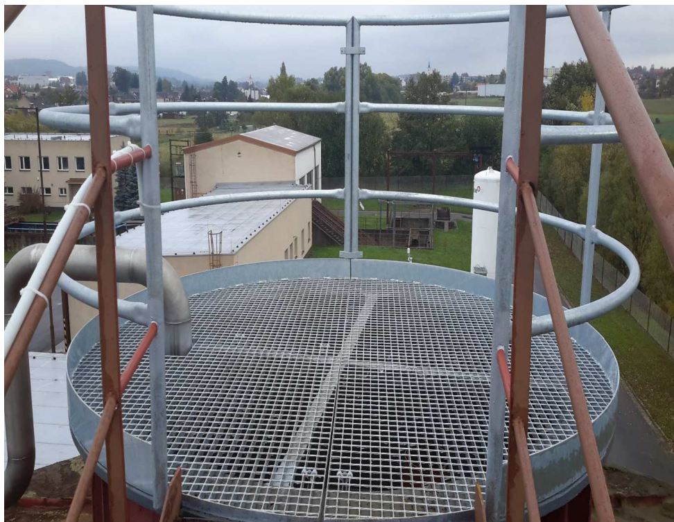
Obr. 2. Pohled do upraveného otevřeného víka vyhnívací nádrže
